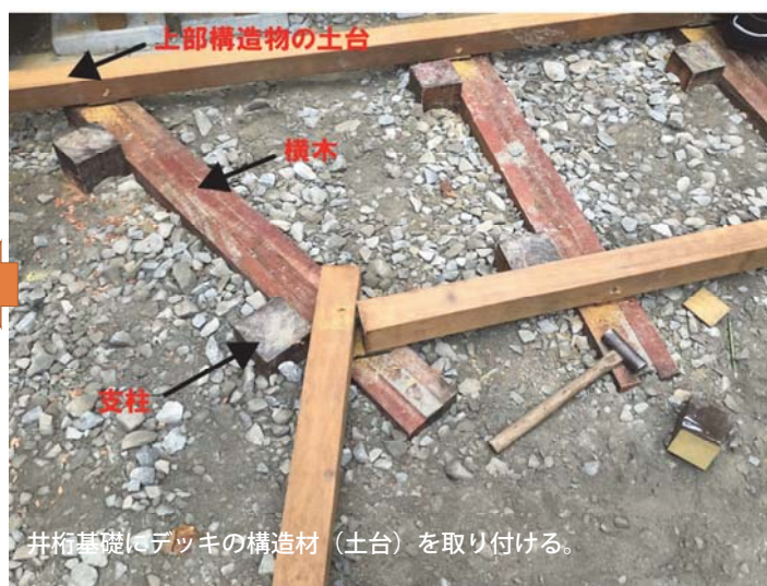
打ち込んだ杭に横木を取り付け養生。
