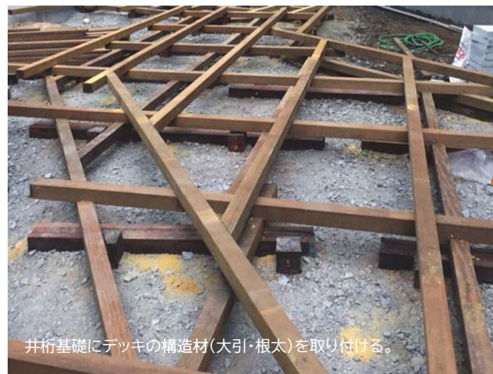
井桁基礎にデッキの構造材（土台）を取り付ける。
